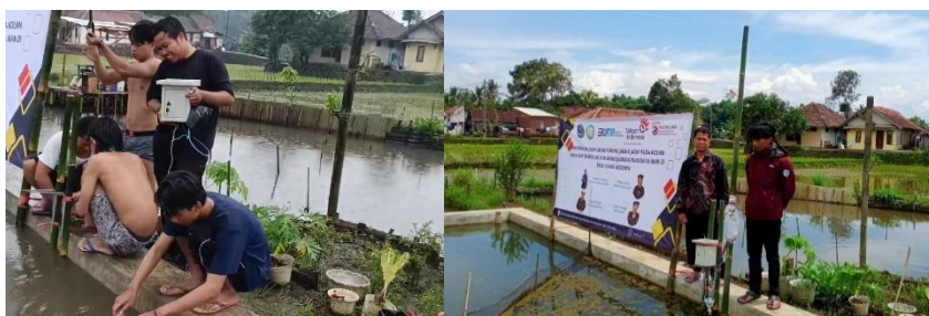
Gambar 1. Pemasangan Perangkat IoT
