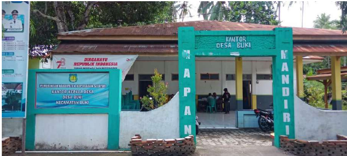
Gambar 1. Kondisi Tampak Luar Kantor Desa Buki
